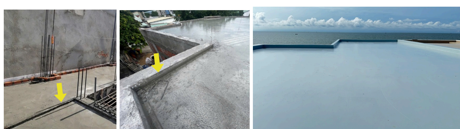
Hình ảnh: Tạo gờ bê tông chống thấm
