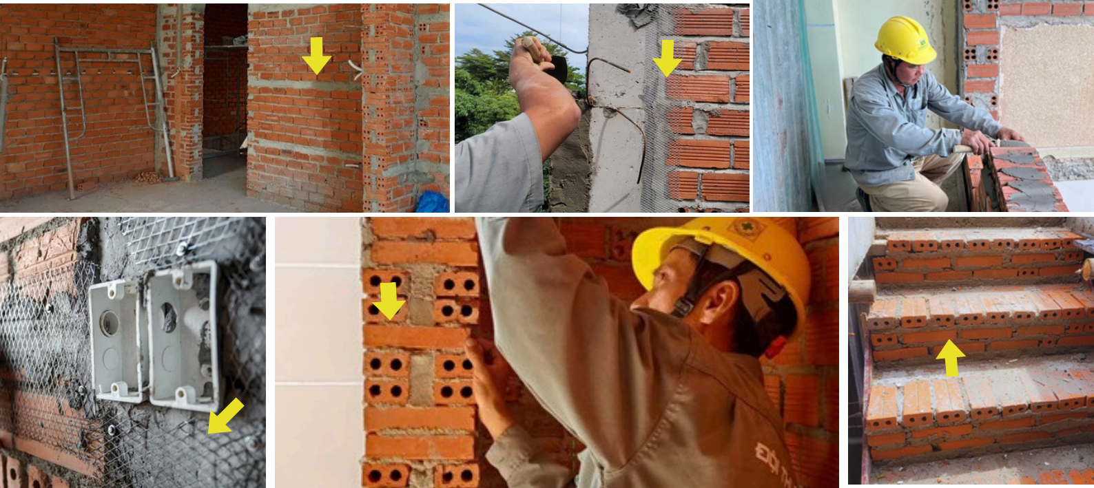
Hình ảnh: Công tác xây tường
