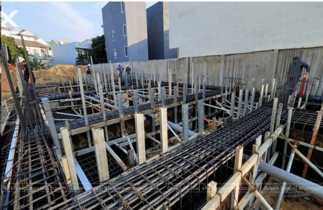
Hình ảnh: Thi công thép theo đúng bản vẽ
