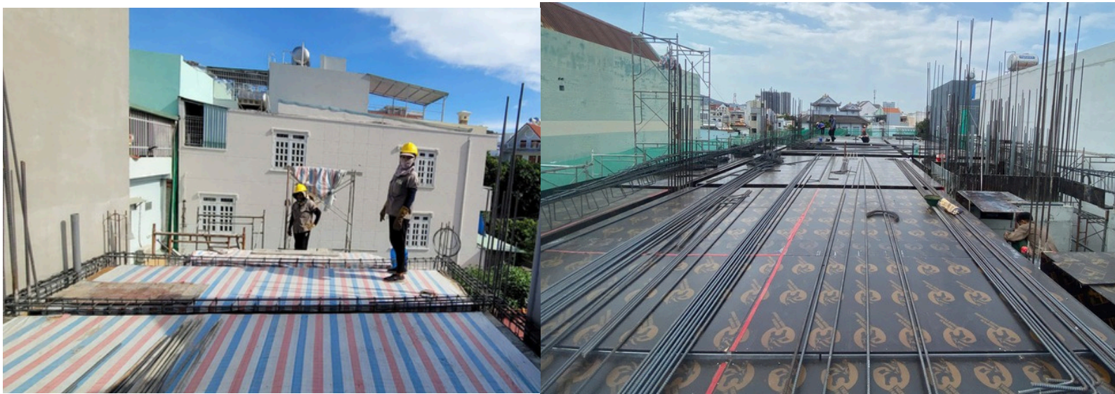
Hình ảnh: Công trình sử dụng phim lót hoặc trải bạt
