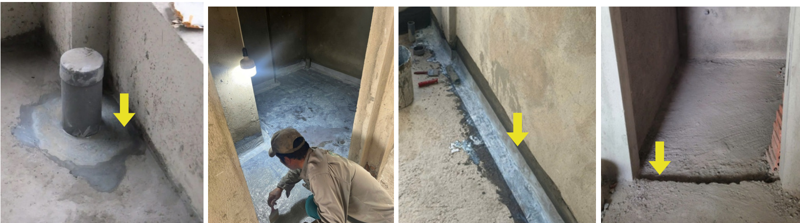
Hình ảnh: Quét chống thấm chân tường-nền WC-cổ ống
