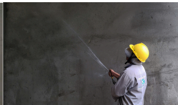
Hình ảnh: Tưới bảo dưỡng tường
