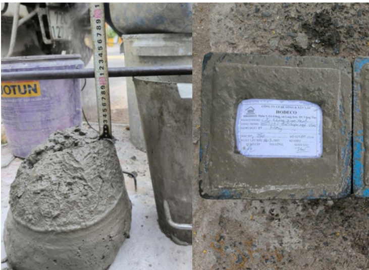
Hình ảnh: Kiểm tra cấp phối-độ sụt
