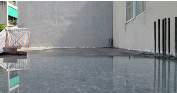
Hình ảnh: Ngâm/tưới bảo dưỡng sau khi đổ bê tông
