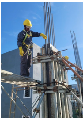
Hình ảnh: Thi công bê tông cột đúng quy chuẩn Hình ảnh: Bê tông cột sau khi tháo đảm bảo láng mịn
