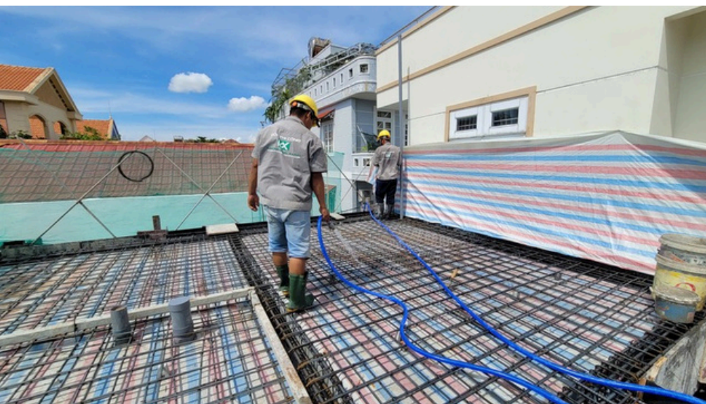
Hình ảnh: Vệ sinh - Kiểm tra sàn kĩ càng trước khi đổ bê tông
