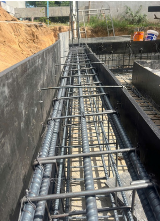
Hình ảnh: Thi công thép móng
