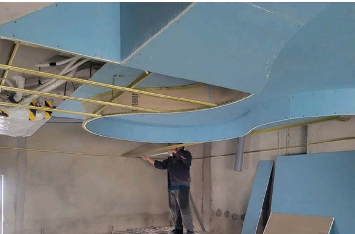
Hình ảnh: Thi công thạch cao bằng laser
