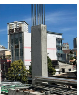
Hình ảnh: Thi công bê tông cột đúng quy chuẩn Hình ảnh: Bê tông cột sau khi tháo đảm bảo láng mịn
