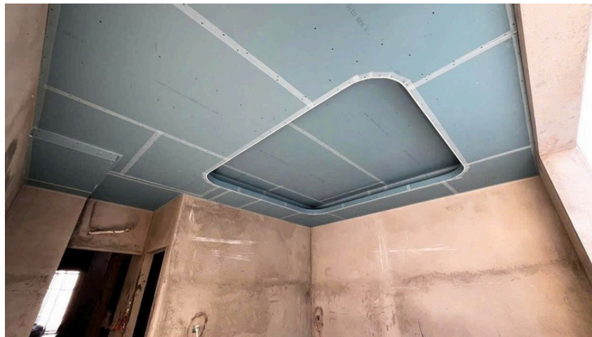
Hình ảnh: Thi công trần thạch cao bằng laser
