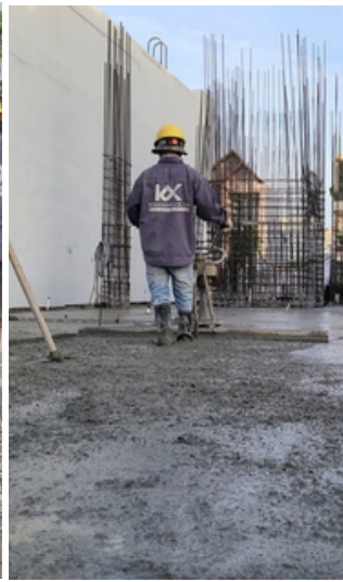
Hình ảnh: Đầm dùi liên tục khi đổ bê tông
