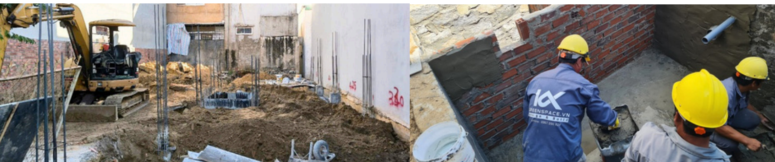
Hình ảnh: Tô trát và xử lý chống thấm bể tự hoại
