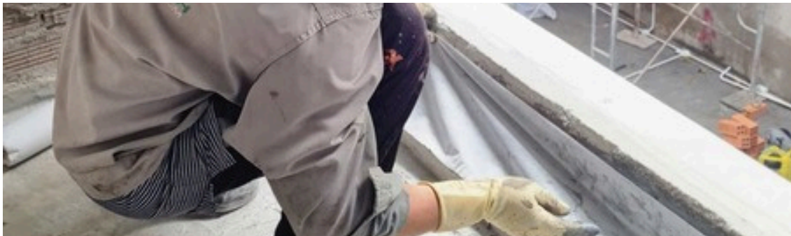
Hình ảnh: Dán lưới gia cường tại các vị trí chống thấm trước khi quét
