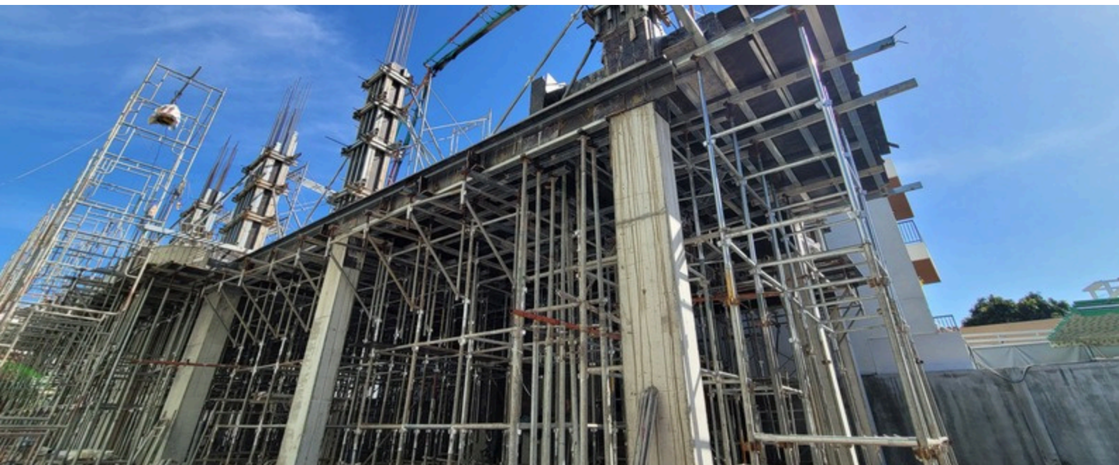
Hình ảnh: Hệ thống chống tăng được mạ kẽm
