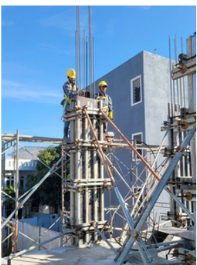
Hình ảnh: Thi công bê tông cột đúng quy chuẩn Hình ảnh: Bê tông cột sau khi tháo đảm bảo láng mịn
