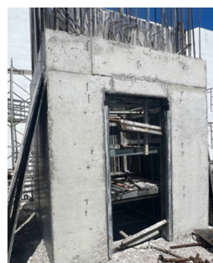
Hình ảnh: Thi công bê tông cột đúng quy chuẩn Hình ảnh: Bê tông cột sau khi tháo đảm bảo láng mịn
