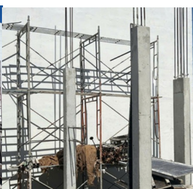
Hình ảnh: Thi công bê tông cột đúng quy chuẩn Hình ảnh: Bê tông cột sau khi tháo đảm bảo láng mịn
