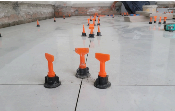
Hình ảnh: Công tác định vị và lát gạch men sử dụng ke, nêm cân bằng
